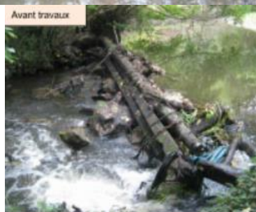
Suppression de l'ouvrage et création d'un radier
